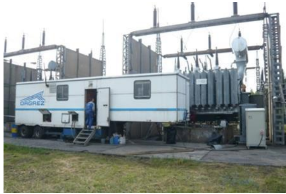
Przewoźna instalacja firmy ORGREZ do regeneracji oleju transformatorowego
